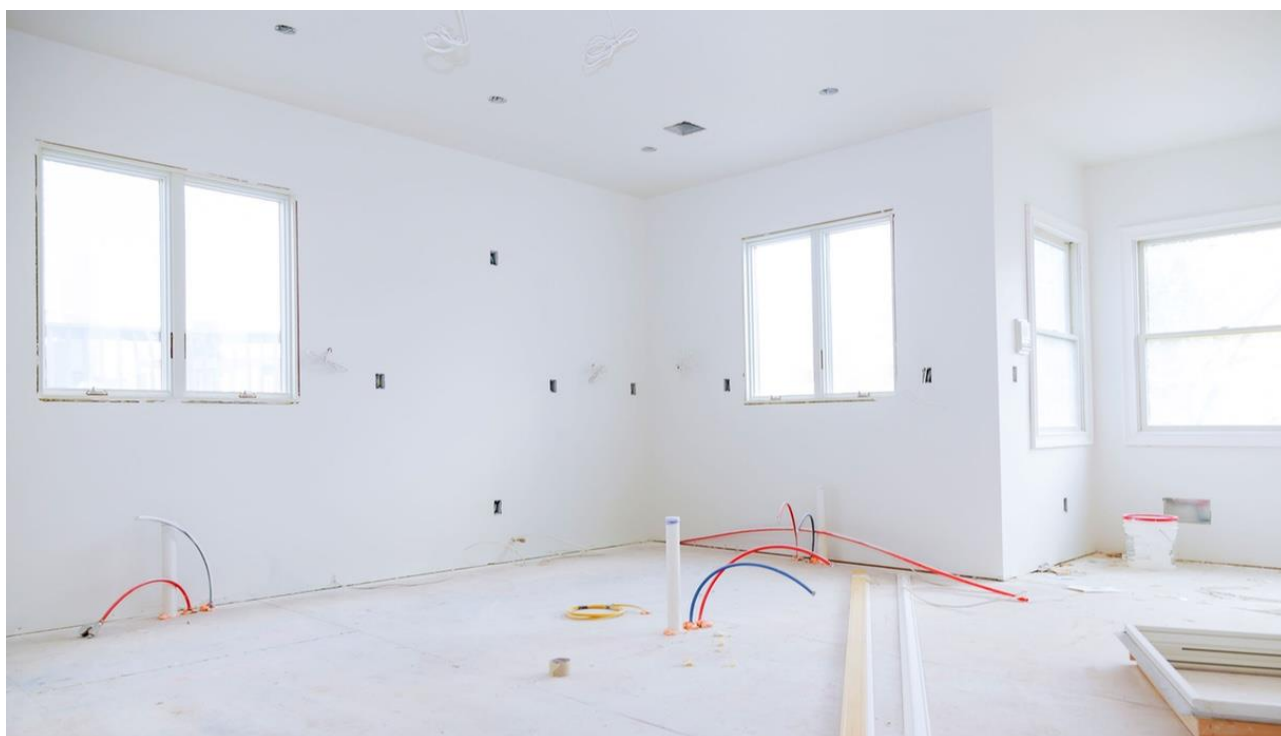
Esempio di pareti perimetrali interne e controsoffitto.
