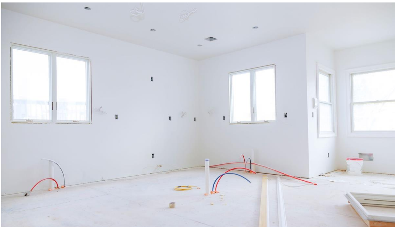
Esempio di pareti perimetrali interne e controsoffitto.
