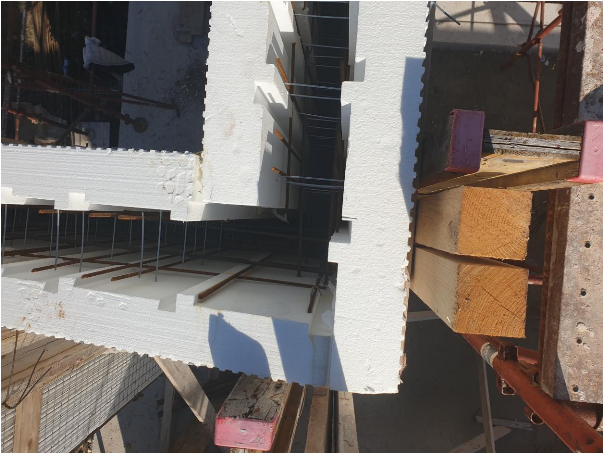
Esempio di solaio di copertura con solaio ultraleggero e coibentato.
